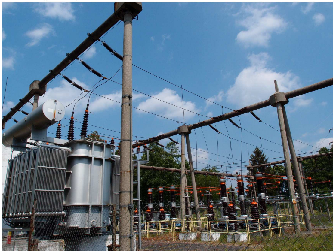
Obr. 4 Transformátor T102 - 110/23 kV TNS Týniště n/O. s převěsy a připojením průchodek 110 kV
