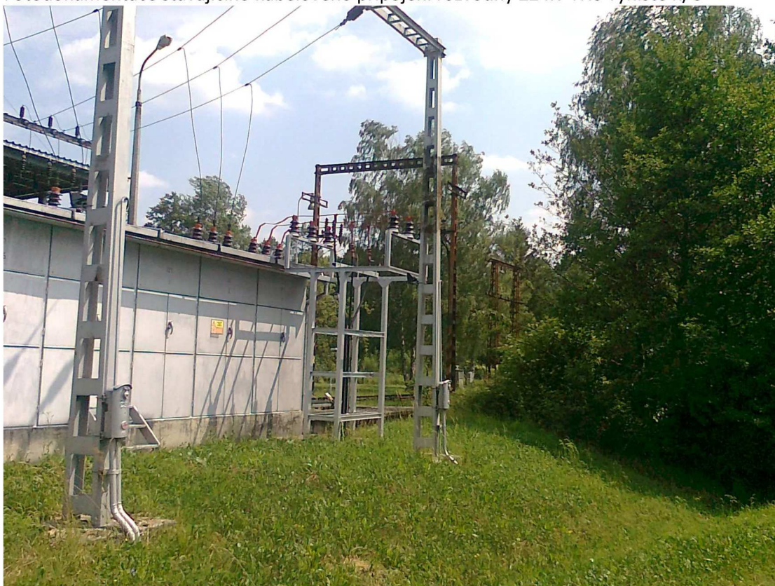
Obr. 5 Přívod kabelů 22 kV od transformátoru T101 k přívodu 1 rozvodny 22 kV
